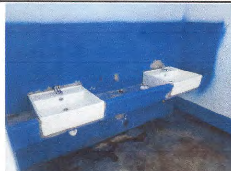
Foto 6: Sustitución de lavamanos baños niños
