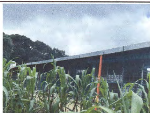
Foto 4: Cambio de canales de metal y bajadas de agua pluvial
