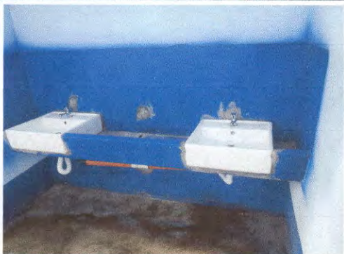
Foto7: Cambio de lavamanos, baños niñas
