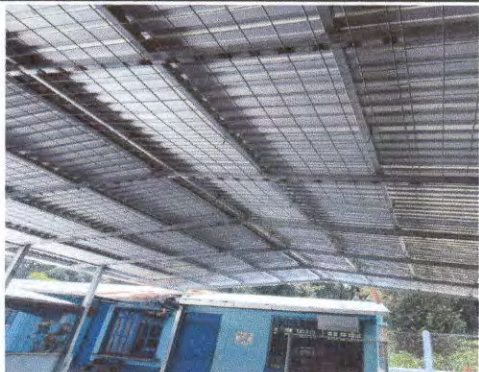
Foto 1: Estructura y techado cancha de la escuela,
