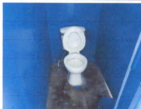
Foto 10: Cambio de 4 inodoros baños de niños
