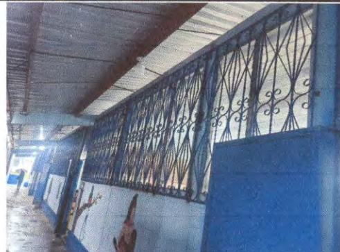
Foto 8: Colocación de 46 metros cuadrados de balcones
