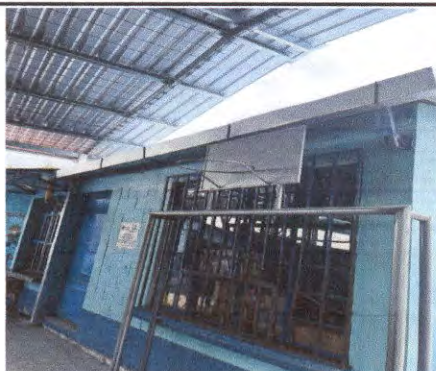
Foto 3: Colocación canales de metal
