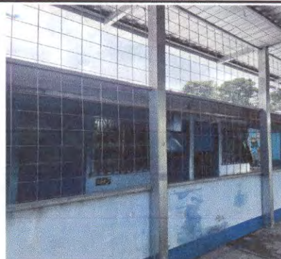
Foto 2: Colocación electromaya parte lateral
