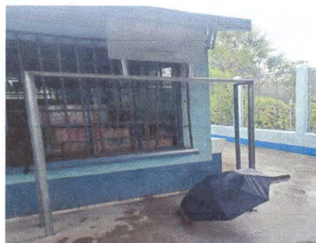
Foto 12: Sustitución de balcones de metal
