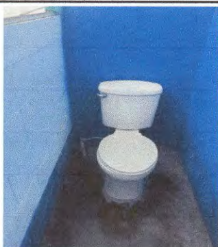
Foto 11: Cambio de 2 inodoros baños de niñas
