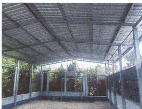
Foto 9: Colocación de electromaya
